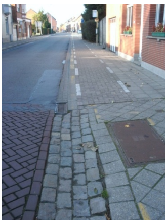
Foto 4.30 Oncomfortabel oprijden, de fietser moet door een goot in kassei
