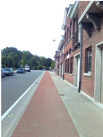
Foto 4.41 Fietspad op niveau doorgetrokken
