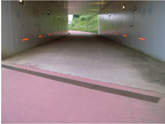
Foto 4.42 Dwarse rooster voor waterafvoer waarvan het bovenvlak perfect aansluit bij het materiaal van het fietspad – de fietser ervaart geen discomfort
