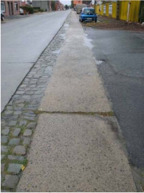
Foto 4.35 Regelmatig grote onvlakheden tot 2,5-3 cm
