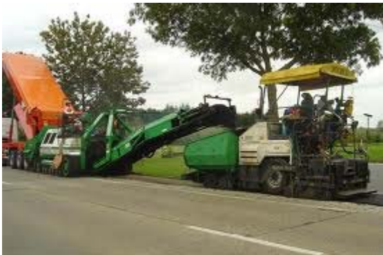
Foto 4.39 Affrezen van fietspaden in asfalt
