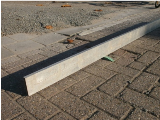
Foto 4.32 Het fietspad kent over de hele lengte brede en vrij diepe voegen (breedte meer dan 1 cm) en kent op sommige plaatsen tot 2 cm plots een niveauverschil, meestal omwille van verzakte klinkers
