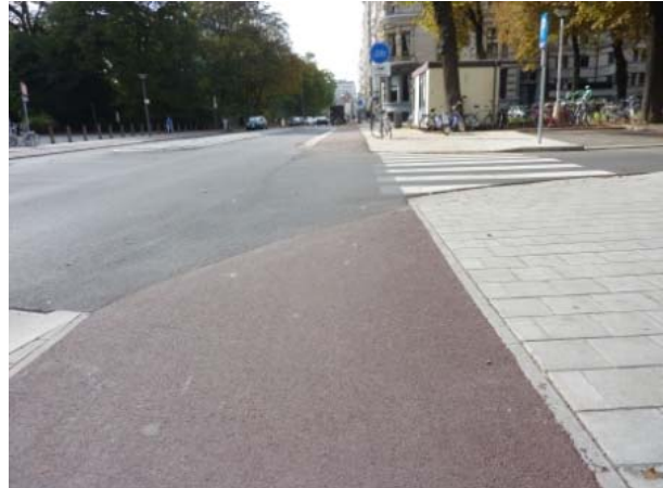
Foto 4.29 Fietspad zowel in het ontwerp als op het terrein aangelegd met speciale aandacht voor het naadloos aansluiten van het fietspad aan de rijweg
