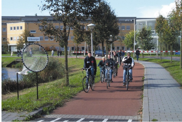
Foto 4.45 Vrijliggend fietspad met eigen verlichtingsinfrastructuur
