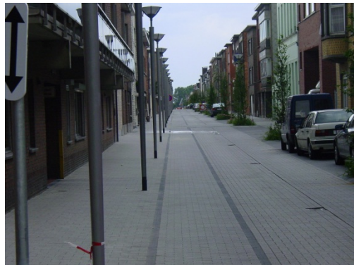
Foto 4.17 Fietssuggestiestrook in betonstraatstenen Vilvoorde
