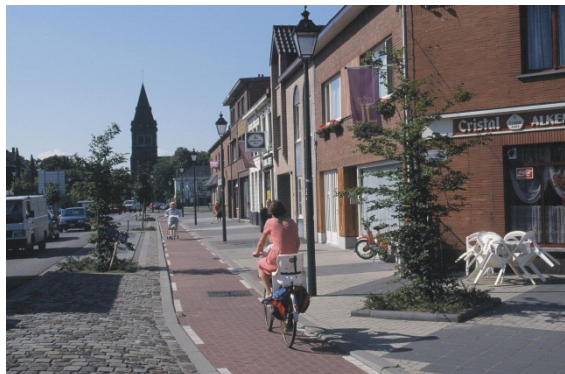
Foto 4.3 Vrijliggend fietspad met veiligheidsmarge ten opzichte van de parkeerstrook – Leopoldsburg
