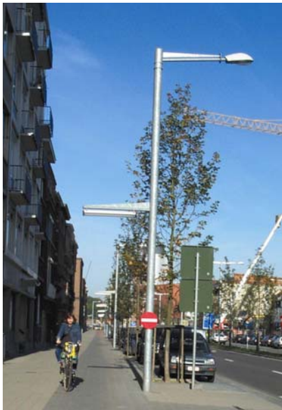
Foto 4.48 Lichtmast met twee lichtpunten - Leuven
