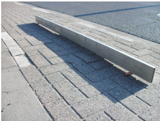
Foto 4.34 Hier en daar zijn er hoger uitstekende gedeelten waarover de fietser heen moet fietsen
