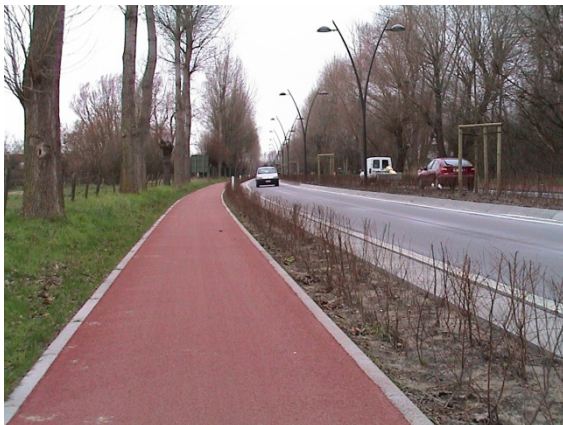
Foto 4.6 Fietspad in asfalt – Koksijde
