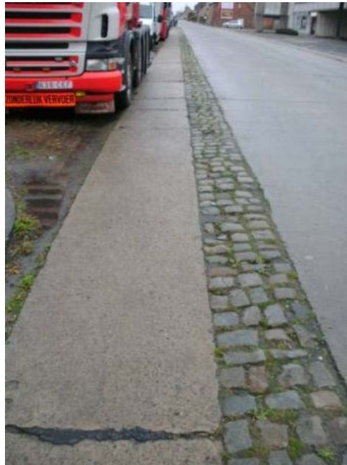
Foto 4.38 Breuklijnen op regelmatige afstand
