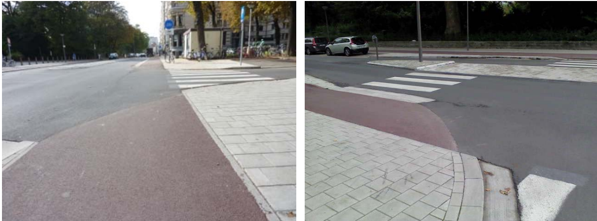
Foto 4.40 Afzagen van de boordstenen en goot zorgt mede voor een comfortabele overgang
